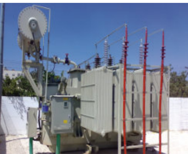
Transformador de 2 MVA, 27,6 x 0,6 kV fornecido para o Canadá
