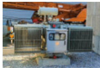
Transformador de potência de 12,5 MVA, 60 Hz, fornecido para a Coreia do Sul .
