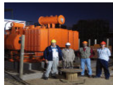
Transformador de 7,5 MVA instalado na mina de diamantes De Beers, Namíbia .
