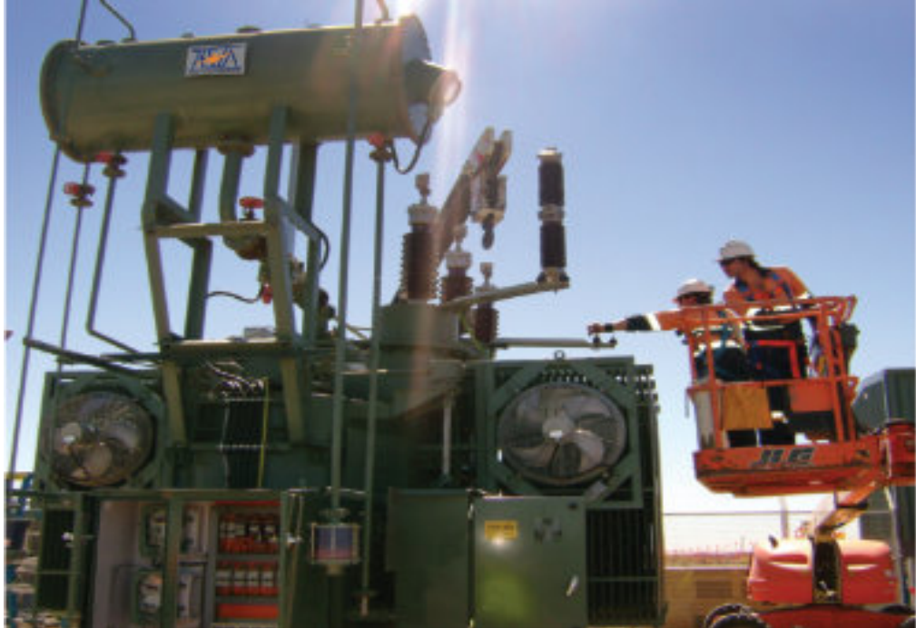
2.5 MVA, 66 kV: Transformador fornecido para a Austrália
