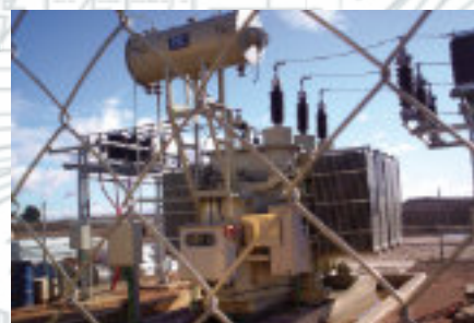
Subestação Solar UTE de 10-12,5 MVA, 66-20 kV fornecida para a Espanha
