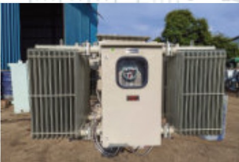
Transformador de serviço de 1 MVA, 4,16/0,48 kV, 60 Hz fornecido para o Texas, EUA
