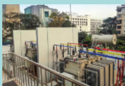
20/28 MVA, 33/11 kV: Transformador de potência fornecido para a DESCO, Bangladesh.
