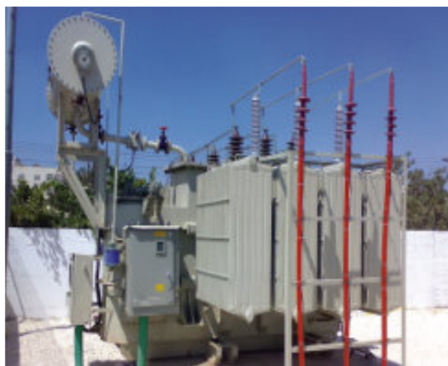
Transformador de 2 MVA, 27,6 x 0.6 kV suministrado a Canadá
